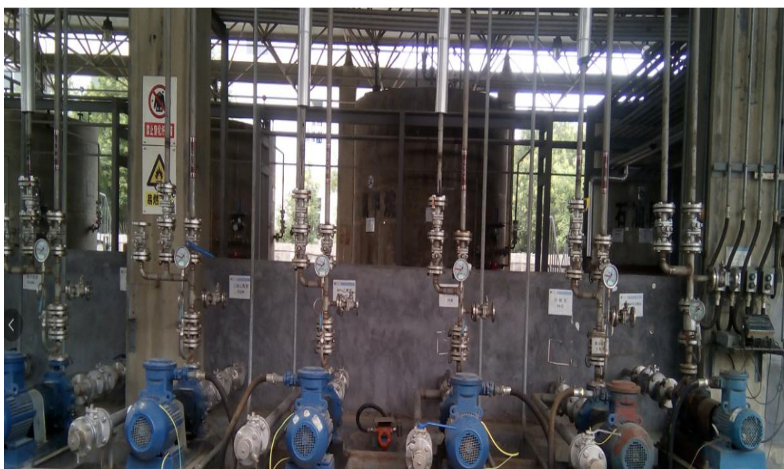
罐区磁力泵输送
