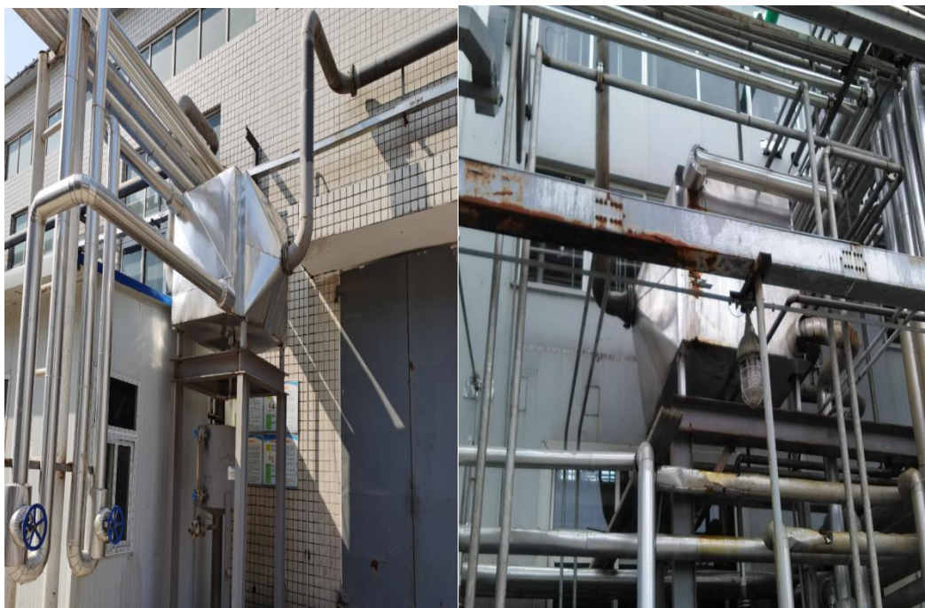
6.1.4 废气输送管道
