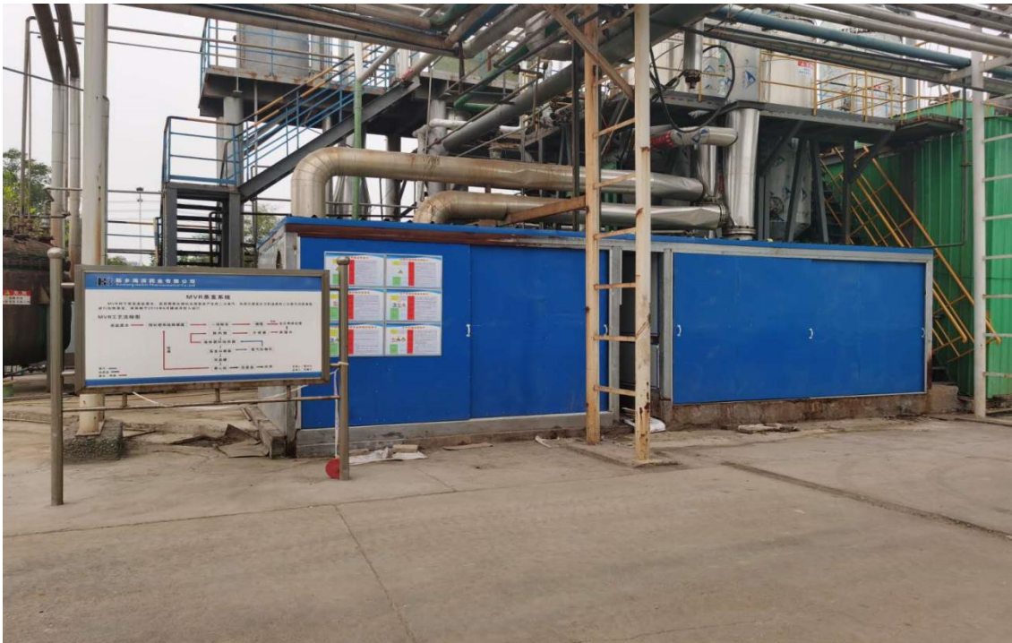
附图 老 MVR 压缩机密闭
